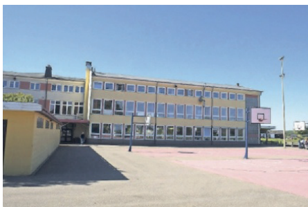
14 Klassenräume in der oberen Etage des Altbaus werden ab den Sommerferien für insgesamt 1,4 Mio. Euro saniert. Foto: P. Förster
