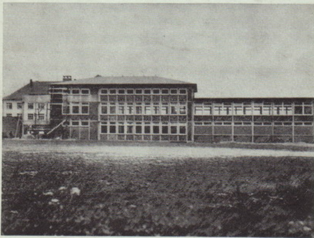
Westansicht des Neubaus vor der Fertigstellung
